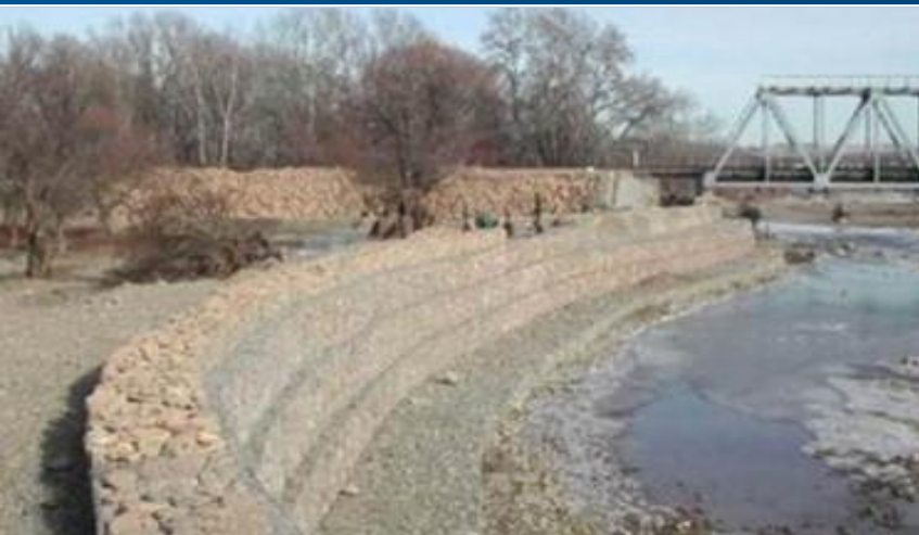
Восстановительные и берего-укрепительные работы на 27 км перегона Ураковская – Эркен – Шахар Северо-Кавказской ЖД
