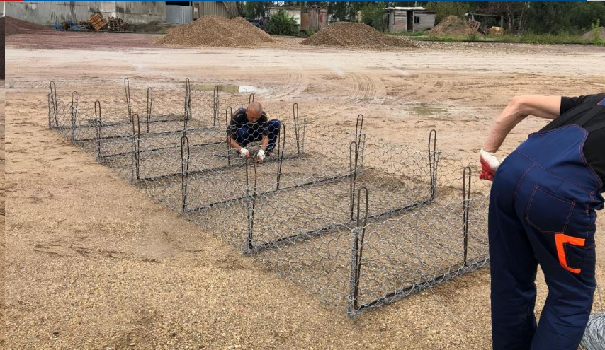
Монтаж закладных деталей
