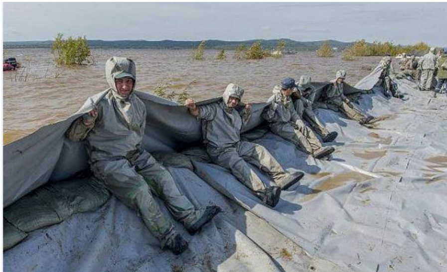
Ручное заграживание и перенаправление водного потока
