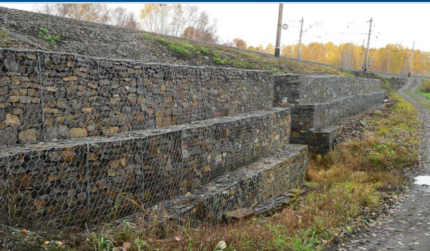
Крепление насыпей жд
