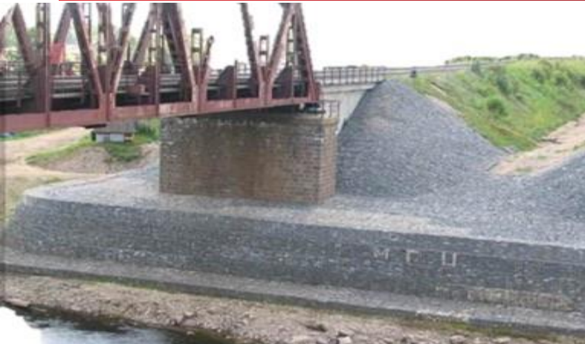
Укрепление конусов мостов через реку Кубена на 587 км перегона Харовская – Пундуга Северной ЖД
