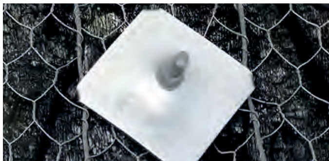
Анкер с прижимной пластиной
