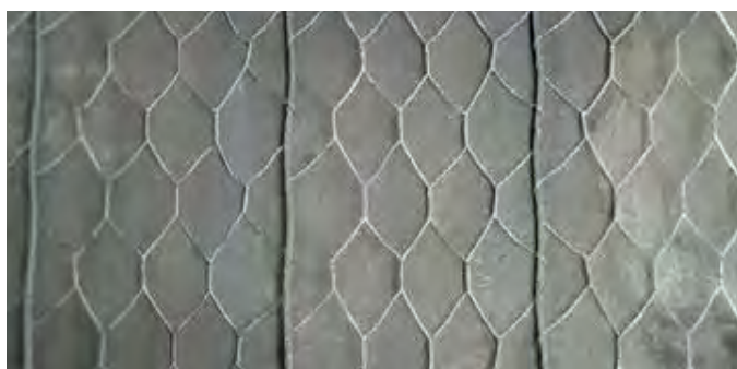
Высокопрочные канаты объединенные сеткой двойного кручения
